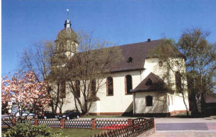
Südwestansicht der Schwemlinger Pfarrkirche mit Langhaus, Chor und Turm. Neubarocke Gestaltung prägt vor allem den Chor und den Turm der Kirche.
