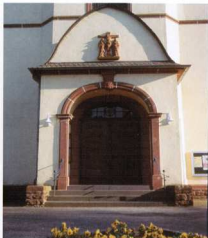
Hauptportal in der Turmfassade mit Korb- bogenabschluss und Schutzdach
