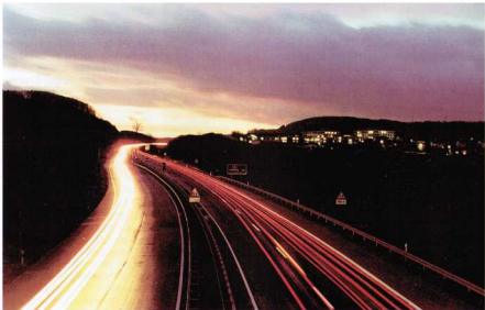
Abendliche Stimmung an der Autobahn 8 bei Schwemlingen. Der Blick geht hier von der Autobahnbrücke in Richtung Westen.
